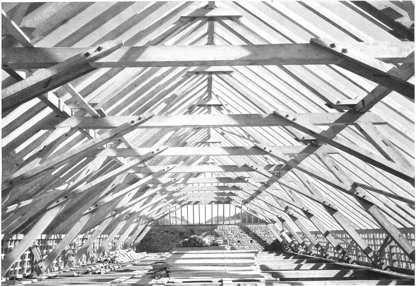
Dachstuhl und Balkenlage für Heuboden
