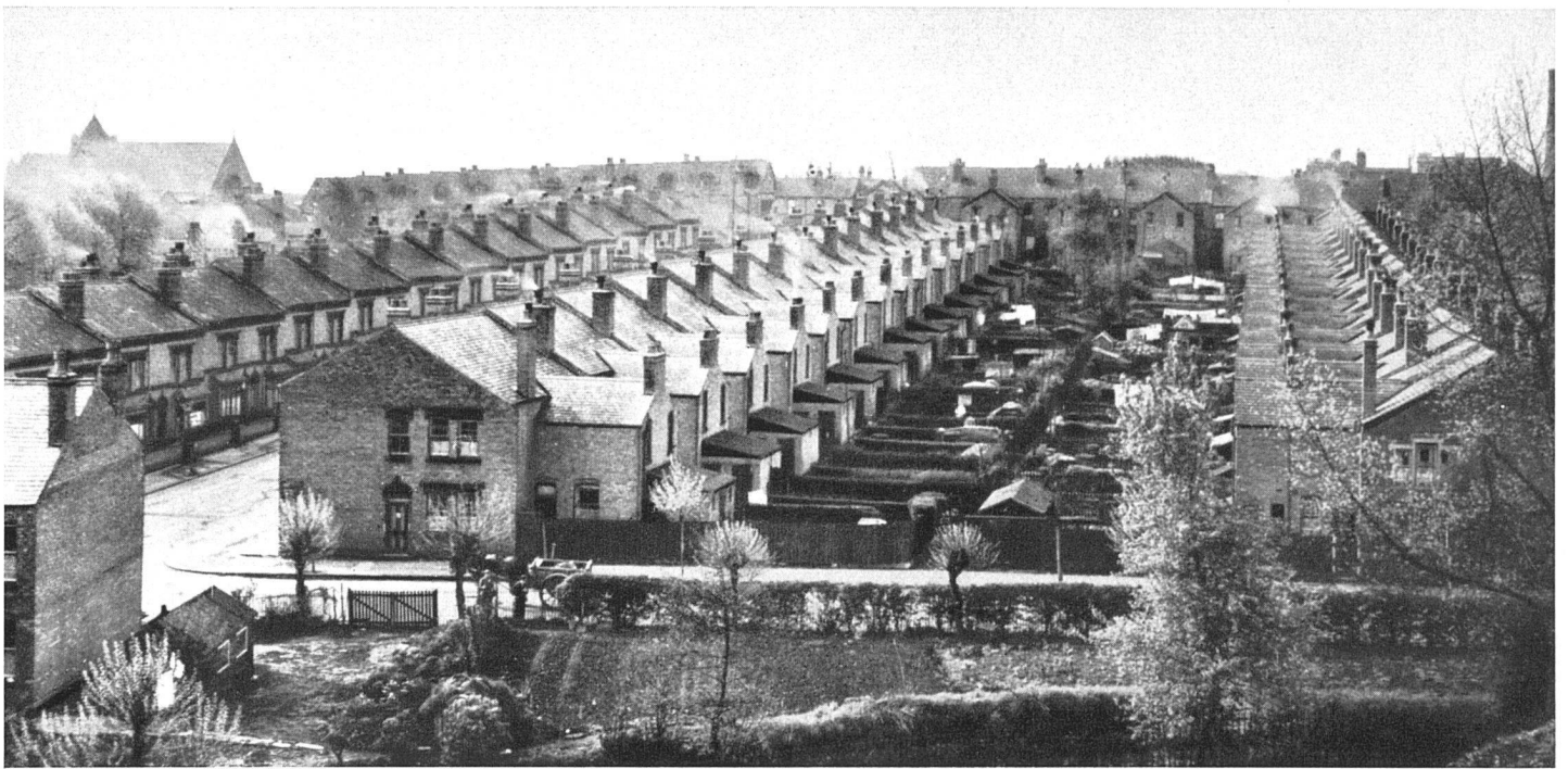
Maisons ouvrières typiques du 19 e siècle: «tunnel-back houses» à Birmingham
