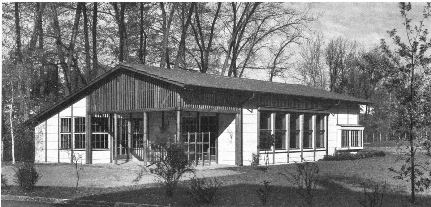
Abb. 20 Kindergarten Egelsee, 1944/45, Gesamtansicht von Südwesten. Ausführung in «Durisol»-Bauweise. Städt. Hochbauamt, Projektbearbeitung und Ausführung durch Arch. BSA H. Daxelhofer und Arch. SIA K. Müller, Bern | Vue générale du sud-ouest. Construction système «Durisol» | General view from the south-west. Construction «Durisol» System
