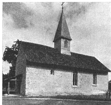
Das Äußere nach der Restauration
