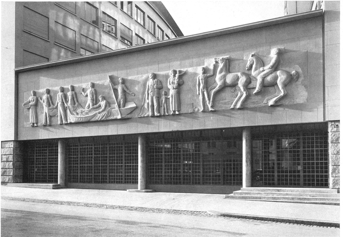
Eingang mit versenkbaren Gittern. Relief in Sandstein von Luigi Zanini, Zürich | Entrée principale; les grilles peuvent s'enfoncer sous le sol | The main entrance, trellises slide into the floor
