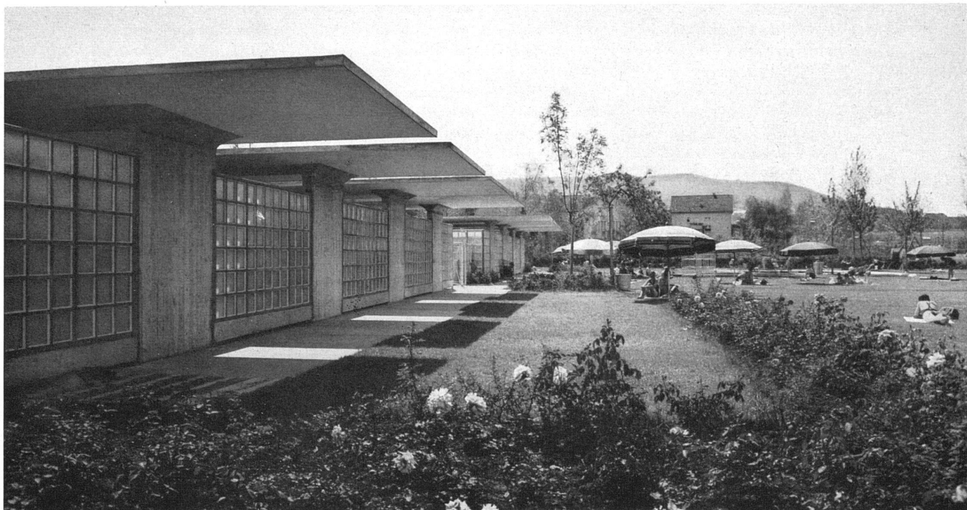
Freibad Allenmoos Zürich 1938/39. M. E. Haefeli & W. M. Moser, Arch. BSA. Frauengarderoben mit Blick in den Park | Bain en plein air «Allenmoos» | «Allenmoos» open air bath
