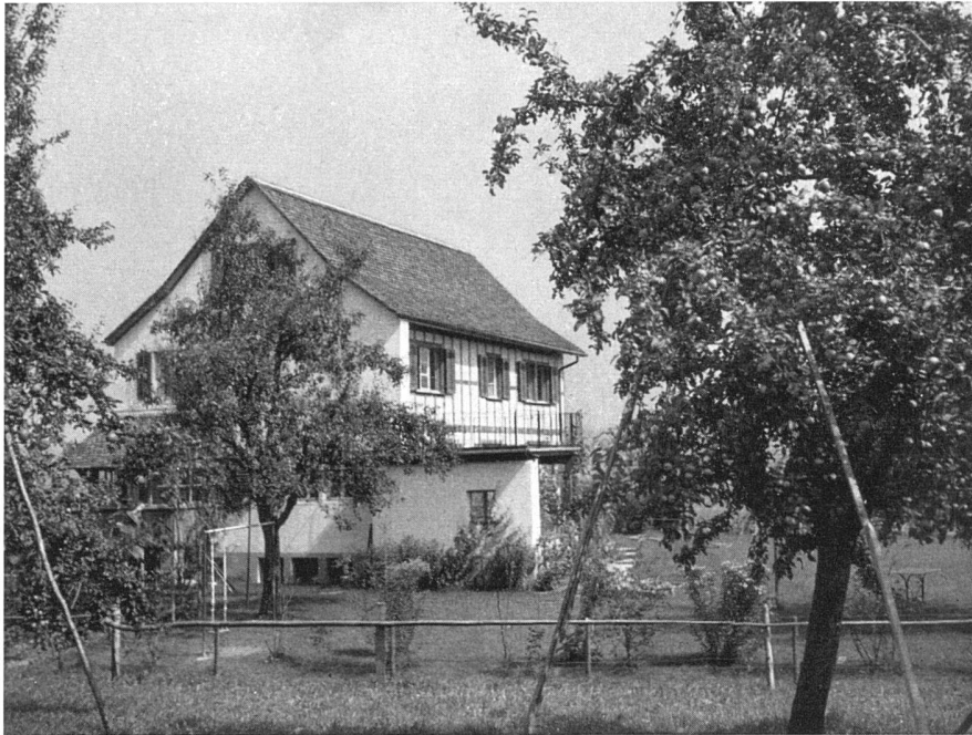
Wohnhaus in Thalwil. Max Kopp, Architekt BSA, Zürich. Ansicht von Westen / Maison à Thalwil, vue de l'ouest / House in Thalwil, view from the west
