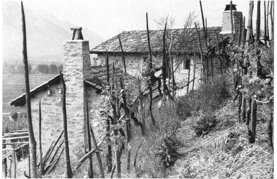
Rückansicht / Le dos de la maison / Back view
