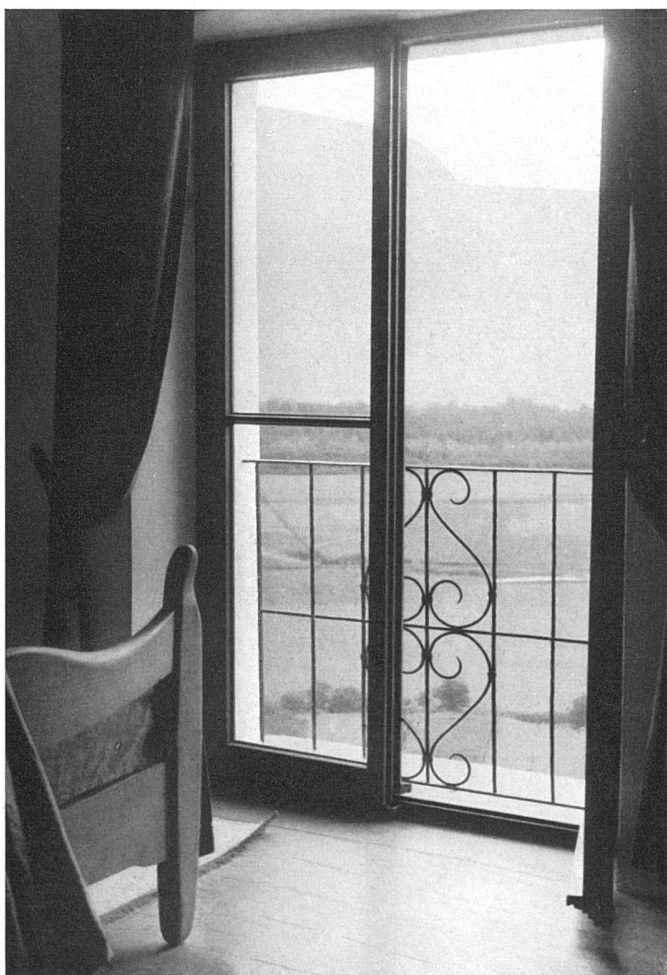
Fenstertüre Obergeschoß / Porte-jenêtre à l'étage / French window on the upper floor
