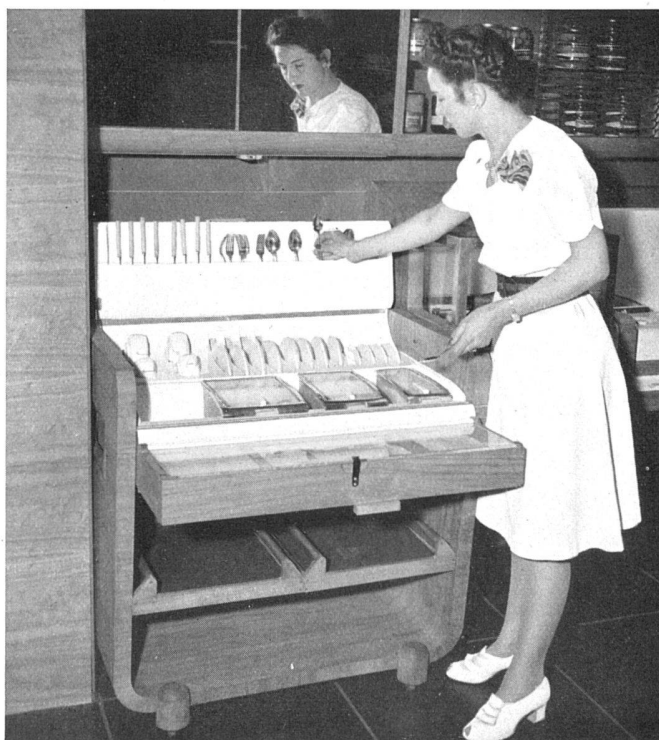
Abb. 11 und 11a. Aufklappbarer Servierwagen, in welchen die Kochtöpfe versenkt und elektrisch weitergeheizt werden können / Wagonnet de service; les casseroles sont enfoncées et maintenues chaudes à l'électricité / Serving wagon; the pans are sunk and kept warm by electric heater
