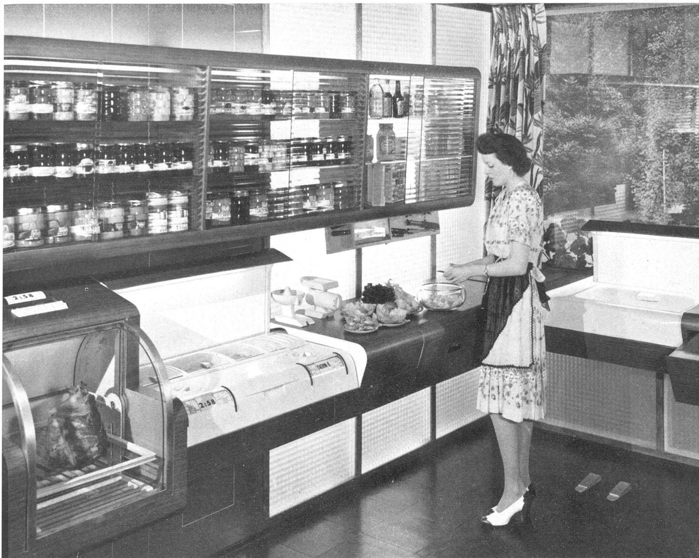
Abb. 10. Elektrische Modellküche mit versenkten, herausnehmbaren Kochtöpfen, 1943. Die Apparate mit Deckeln verschließbar. Backofen und Kühlschrank aus Plexiglas. Libbey, Owens, Ford Glass Co. Entwurf H. Creston Dohner / Cuisine modèle, avec cuisinière électrique à casseroles enfoncées. Tous les appareils ferment à couvercle. Fourneau et frigidaire en verre / Wartime model of electric range with sunken pans. Panels can be lowered over working units. Glass-enclosed oven and refrigerator
