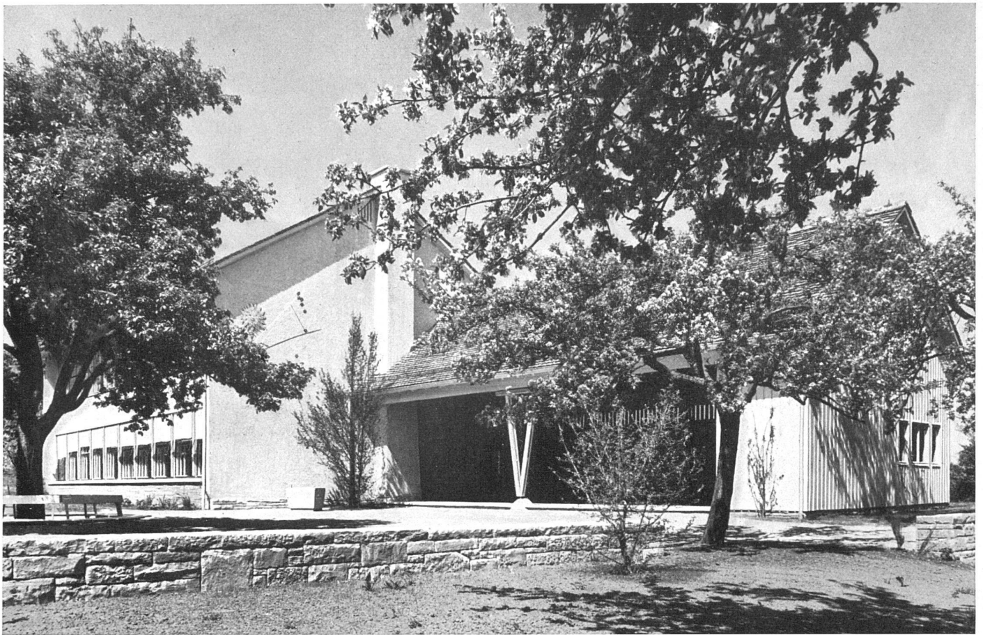
Gesamtansicht von Osten, rechts Pausen- und Turnhalle / Vue d'ensemble (côté est), à droite préau couvert-salle de jeux / General view from the east, at right the play-hall
