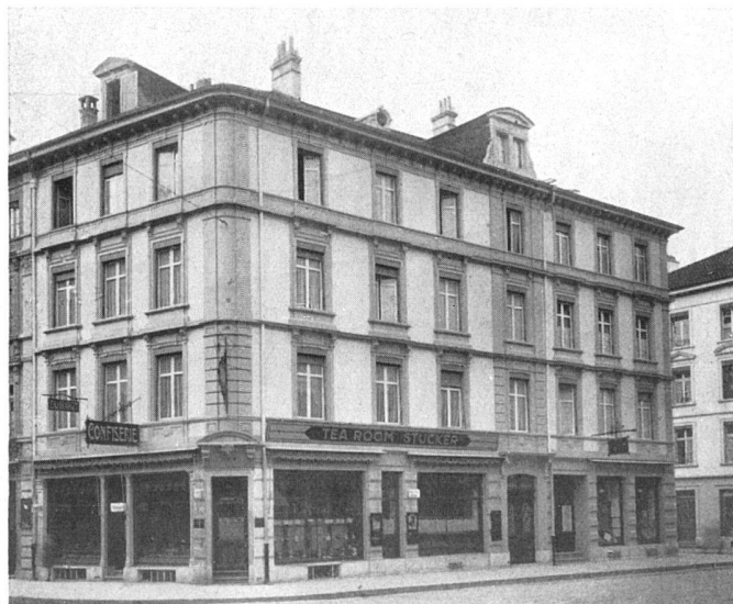
Vor dem Umbau | Etat antérieur | Before the remodelling
