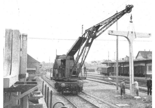
Transport und Montage der Elemente | Transport et montage des éléments | Transport and erection of the units
