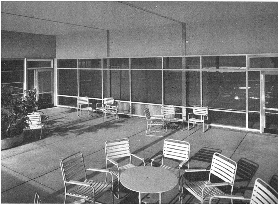
Gartenhalle, Korridorwand fest verglast, Lüftungsflügel über den Türen / Terrasse couverte / Covered terrace for recreation
