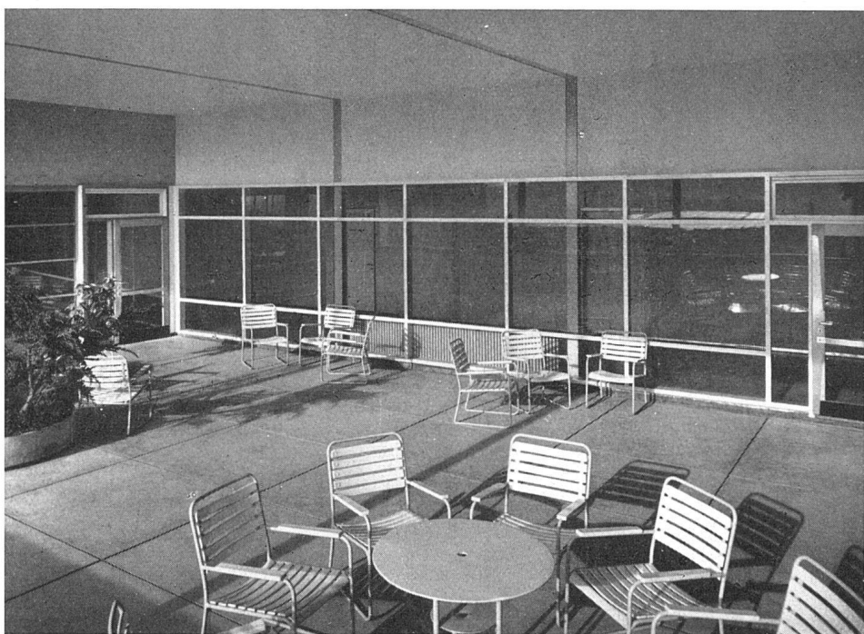
Gartenhalle, Korridorwand fest verglast, Lüftungslügel über den Türen / Terrasse couverte / Covered terrace for recreation
