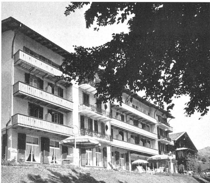
Südfront mit neuem 3. Geschoß und neuen Balkonen / Façade sud de l'hôtel, avec le nouveau 3ème étage / South elevation with new 3rd floor
