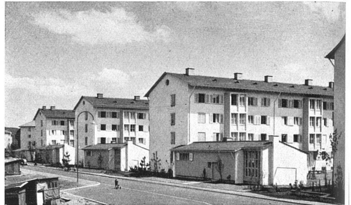
Gesamtansicht der Siedlung von Nordwesten / Vue d'ensemble de la cité prise du nord-ouest / The settlement seen from the north-west
