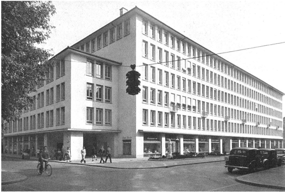
Gesamtansicht von der Talstraße | Vue d'ensemble | General view
