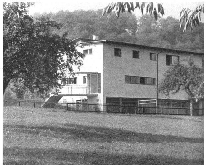
Ansicht von Osten | Façade est | View from the east
