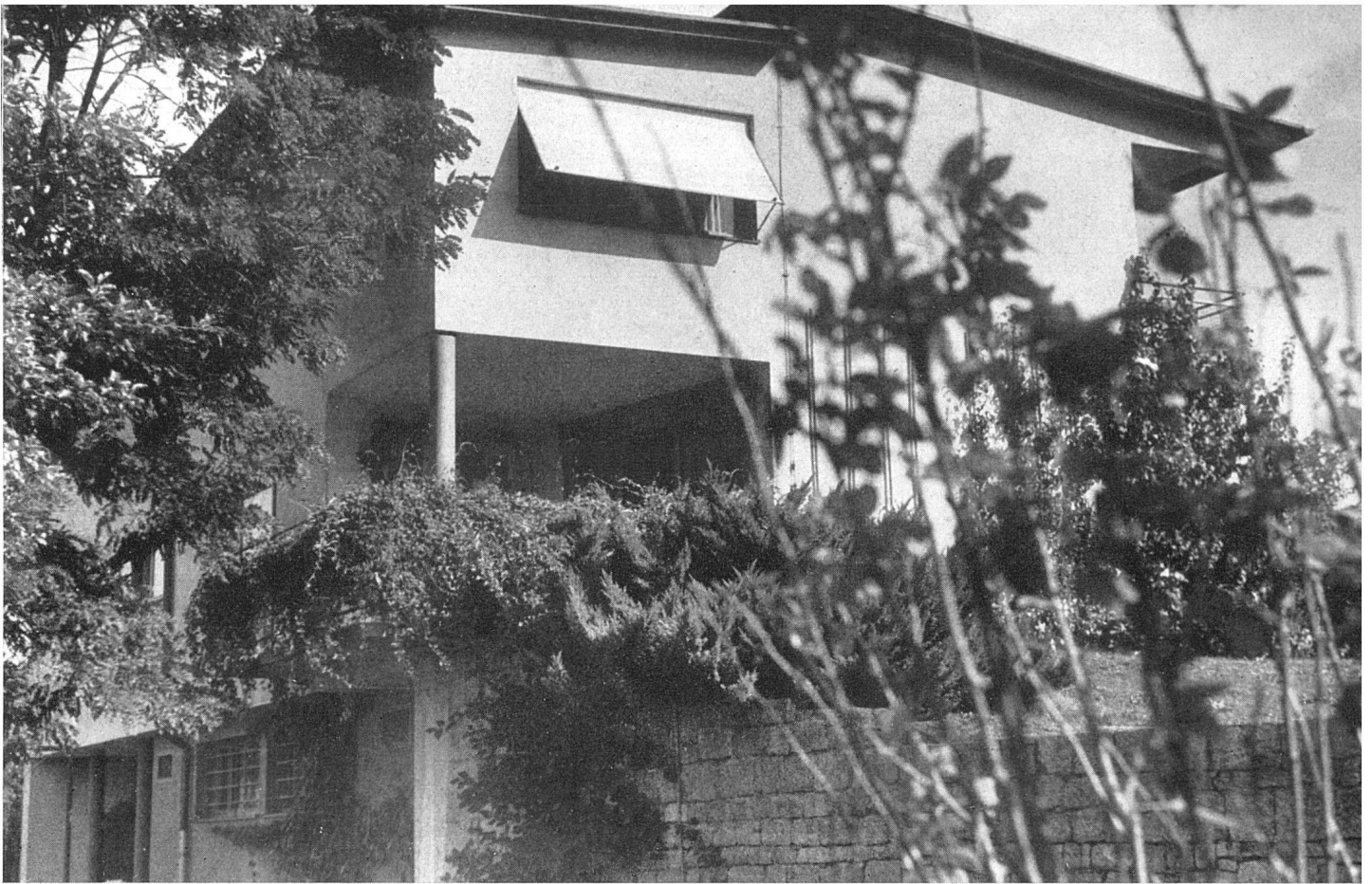
Ansicht von Nordwesten mit Terrasse und Kellerausgang | Façade nord-ouest, avec terrasse et accès au sous-sol | North-west elevation with and basement entrance
