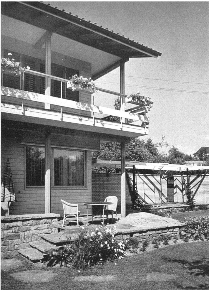
Eckbalkon, Terrasse und Pergola | Terrasse, pergola et balcon | Terrace, pergola and balcony
