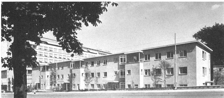
Gesamtansicht von Westen, im Hintergrund Bettenhaus des Bürgerspitals | Façade nord-ouest, à l'arrière-plan le bâtiment principal de l'hôpital | North-west elevation, in the background the main building of the hospital
