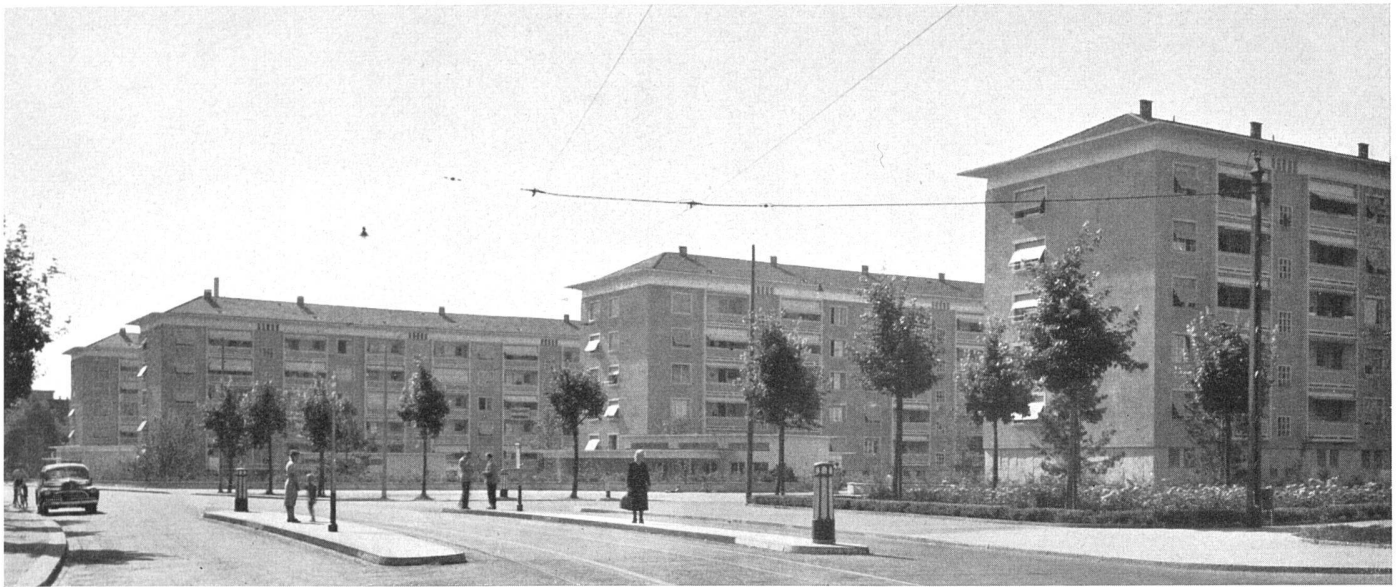
Gesamtansicht von Südosten | Vue générale prise du sud-est | General view from south-east
