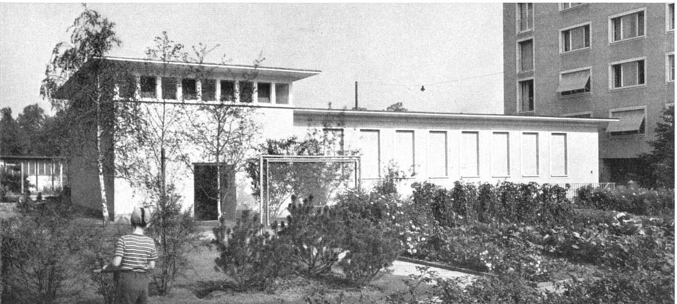
Heizzentrale und Freizeitwerkstatt | Chaufferie et atelier commun | Heating plant and common workshop
