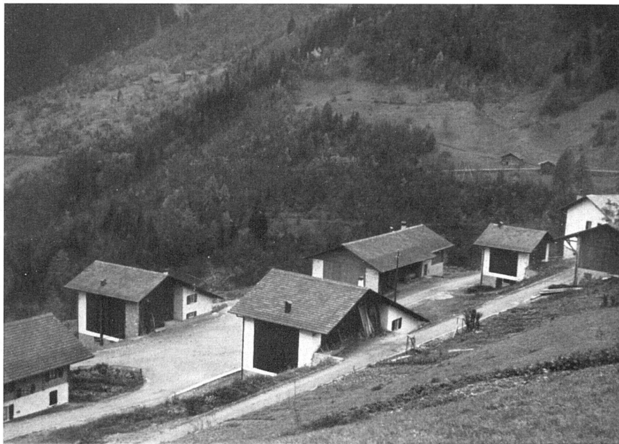
Weiler Mayen (Wallis). Nach dem Brand 1946 wieder aufgebaut in variierten Haustypen | Le hameau Mayen après sa reconstruction | The hamlet Mayen was destroyed by fire and rebuilt in 1946
