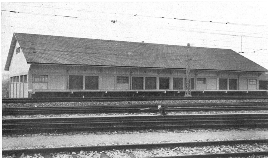
Der Bau von der Eisenbahn aus ge- sehen | Façade vers la vie ferrée | The building seen from the railway
