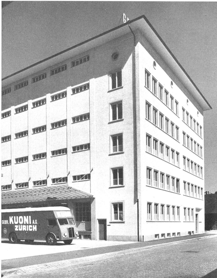
Westansicht mit Büro- und Lagertrakt | Vue ouest avec bureaux et dépôt | View from the west with office and storage wing Photos: Hugo P. Herdeg SWB, Zürich
