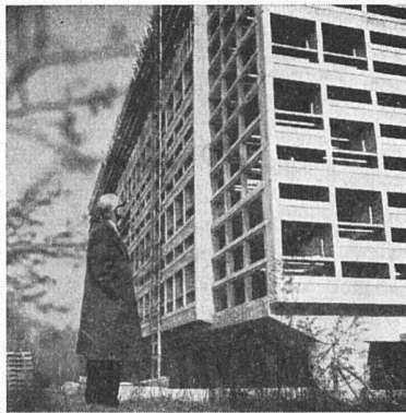
Le Corbusier vor seiner Unité d'Habitation für Marseille Photo: M.R.U.
