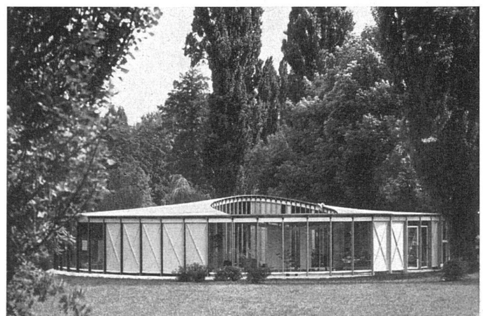
Pavillon der USA aus Holz und Glas mit exzentrischem rundem Innenhof, nach welchem das Dach leicht ansteigt | Pavillon des Etats-Unis | American Pavilion
