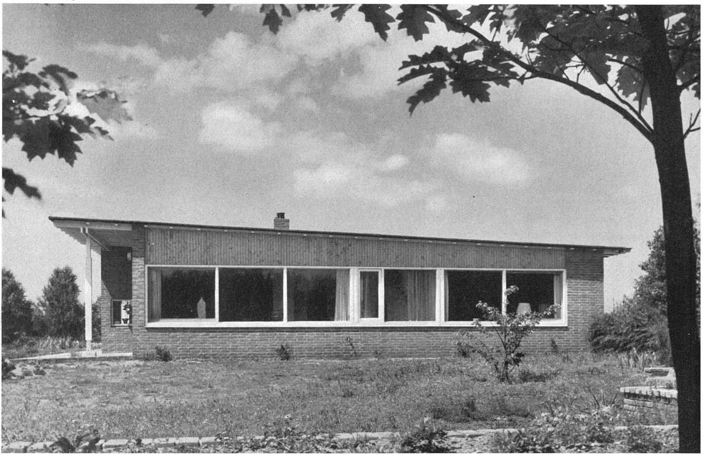
Ansicht von Osten / Façade est / East elevation
