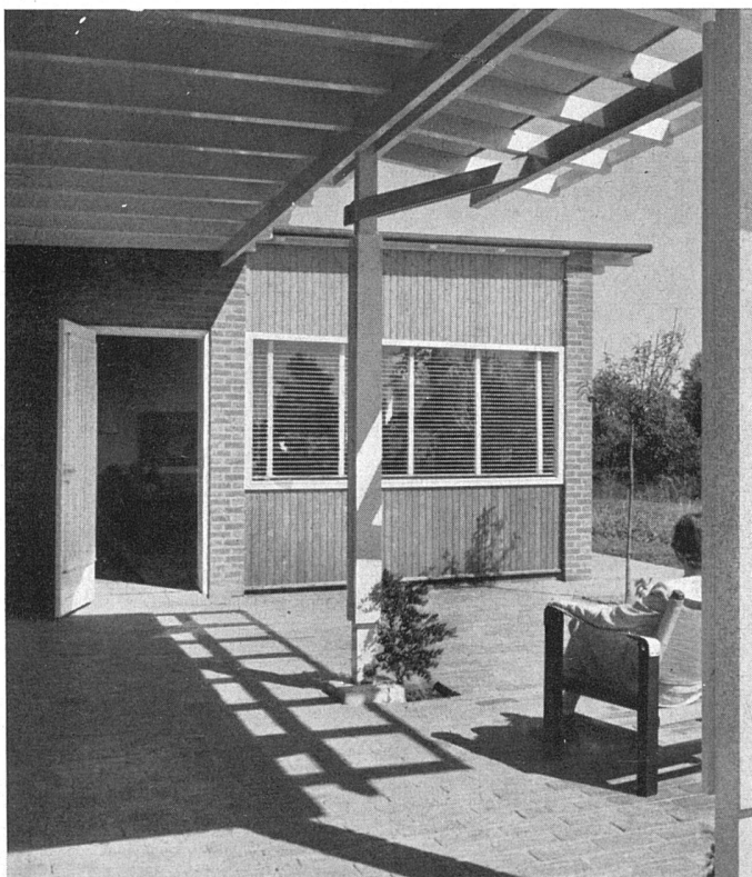
Gedeckte Terrasse mit Eingang Wohnraum / Terrasse couverte / Covered terrace
