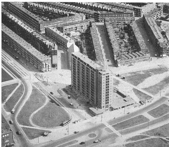
Fliegerbild von Südwesten / Vue aérienne prise du sud-ouest / Bird's eye view from south-east Photo: KLM
