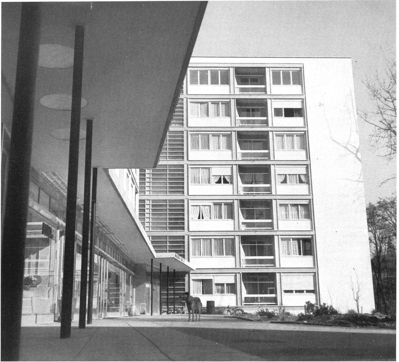
Façade sud de l'aile nord et galerie des entrées et magasins | Südansicht des Nordflügels mit Eingängen und Läden | South elevation of north wing, at left the entrances and shops
