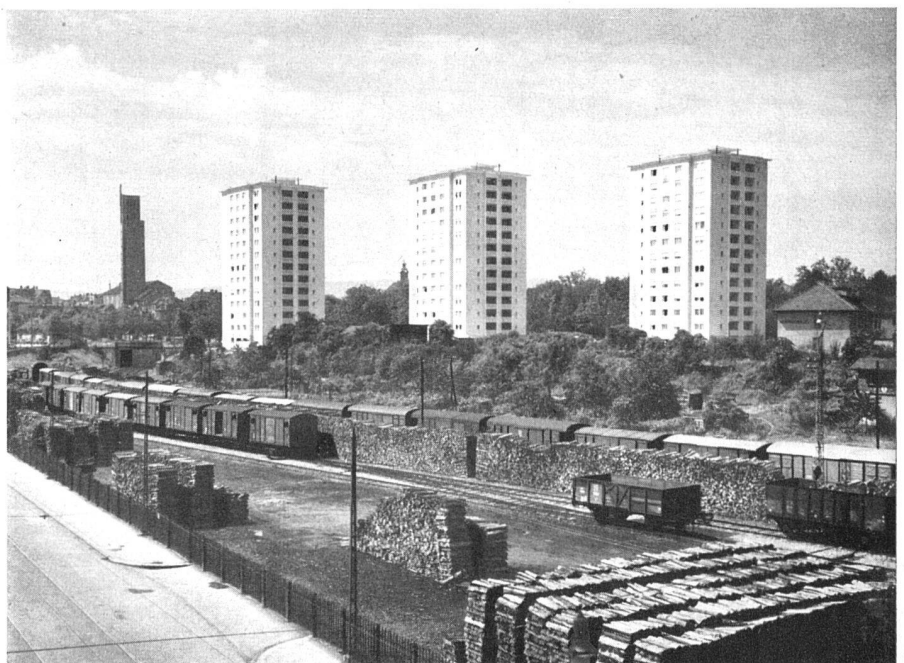
Gesamtansicht von Nordosten, links die St. Antonius-Kirche von Karl Moser | Vue générale prise du nord-est | General view from north-east
