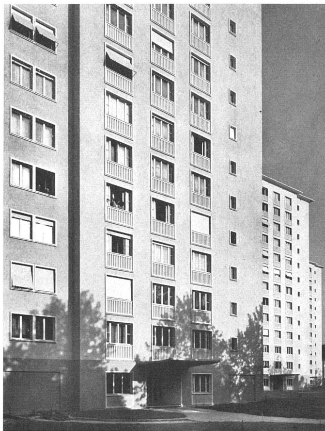
Westfassaden mit Eingängen / Façade ouest avec entrée / West elevation with entrance Photo: Eidenhenz SWB, Basel
