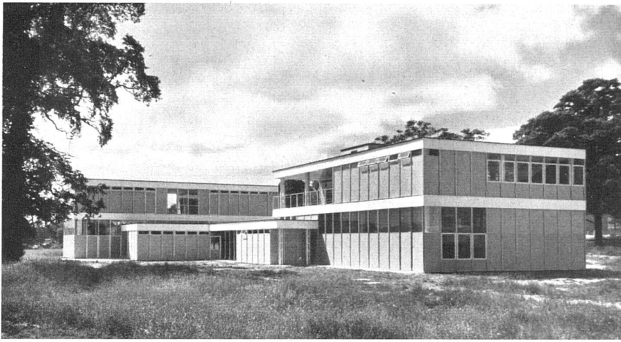
Sekundarschule in Clarendon, Hertfordshire. Außenwände aus vorfabrizierten 3 cm starken Plastikplatten, Stahlskelett. Architekturbüro der Grafenschaft Hertfordshire, Aslin, County Architect | Ecole secondaire faite de panneaux préfabriqués en plastic | Clarendon Secondary School made of prefabricated plastic panels Holoplast Photo: Peter Pitt, London
