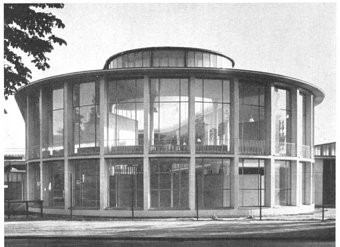
Der Rundbau. Die konsequente Verglasung gewährt Ein- und Ausblicke, öffnet den Ausstellungsbau in den Park | La Rotonde | The two-storey exhibition hall
