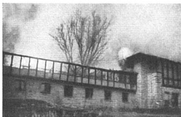
Am 25. April 1952 brannte etwa ein Drittel des ältesten Teils der «Hillside Home School», der von 1902 stammt, auf Taliesin-West nieder. Damit hat das Feuer zum dritten Male seit 1914 das Sommerquartier von Frank Ll. Wright heimgesucht. Opfer des Feuers wurde auch der berühmte Theatersaal, eine der stärksten Raumvisionen Wrights aus jener frühen Zeit. Der durch keine Versicherung gedeckte Schaden übersteigt die Summe von 300,000 Fr. Nach der Auffassung des geprüften Meisters kann eine Rekonstruktion nicht in Frage kommen. Ob er beabsichtigt, einen Neubau vorzunehmen, entzieht sich unserer Kenntnis.
