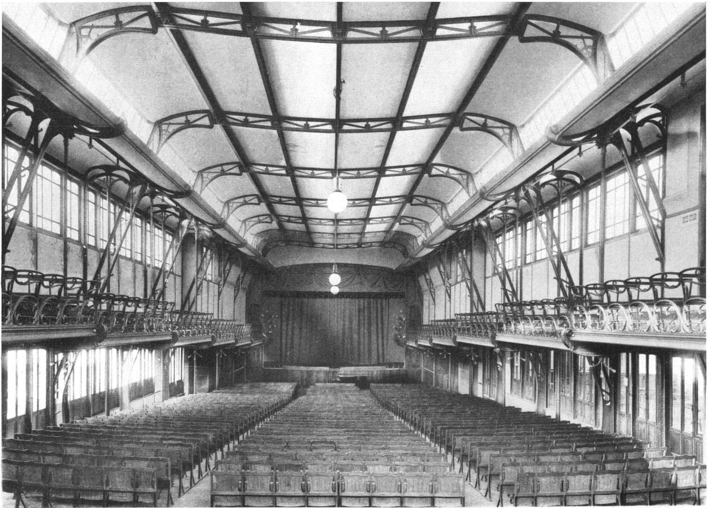
Maison du Peuple, Brüssel, Theatersaal, 1897, Stahlkonstruktion | Salle de spectacle, construction métallique | Auditorium, steel construction
