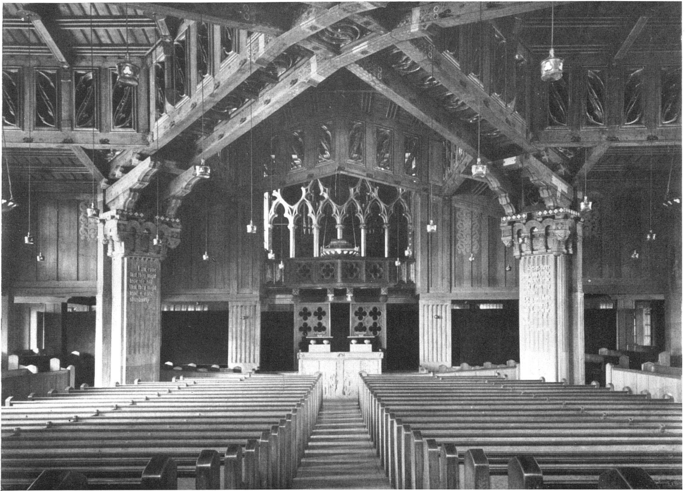
Christian Science Church, Innenraum, Holzkonstruktion, Berkeley, Calif., 1910 | Intérieur d'église, charpente en bois | Interior, timber construction
