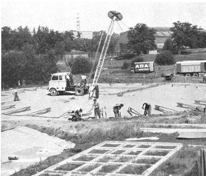
Der Zeltmast wird aufgerichtet | Le mât de la tente est planté | The tent's mast being erected
