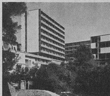
INA-CASA-Quartier Bernabò Brea in Genua
