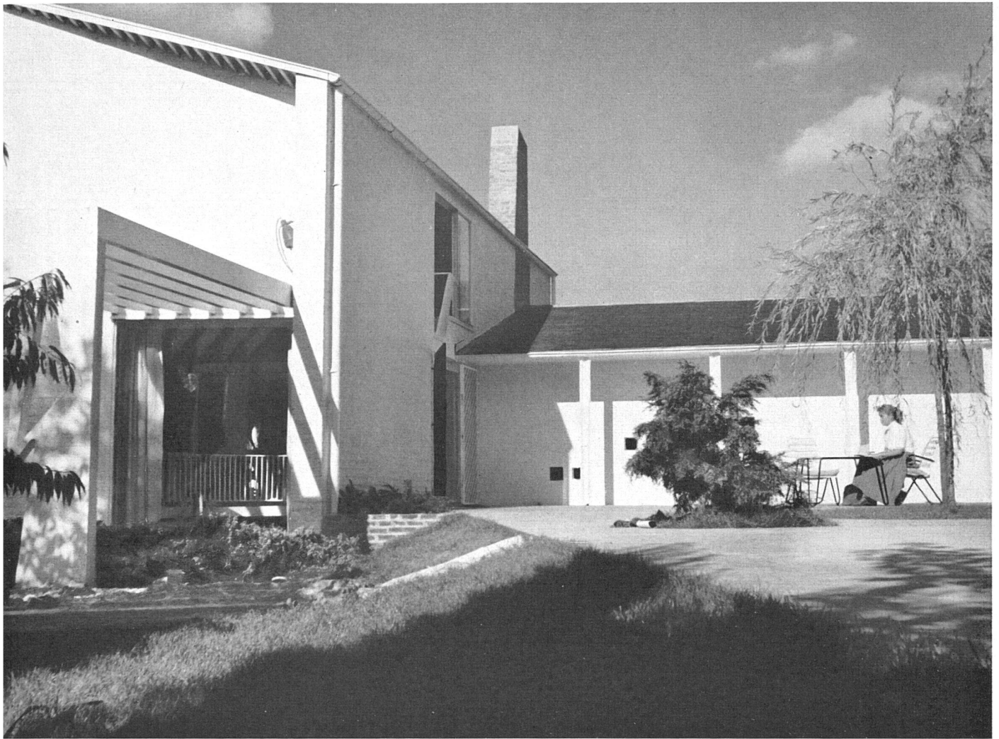
Iaus, Hof und Loggia | Maison, cour et passage couvert | House, courtyard and loggia
