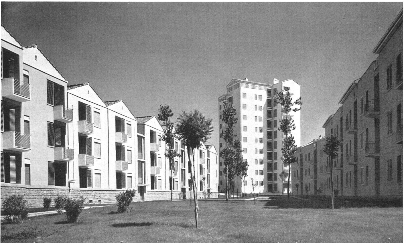
Blick in einen Quartierraum von Nordwesten. Links und rechts dreigeschossige Miethäuser, im Hintergrund Turmhaus | Vue prise du nord-ouest; à gauche et à droite, immeubles locatifs à trois étages; au fond, un immeuble-tour | From north-west, at left and right, three-storey flats; in the background, a point house
