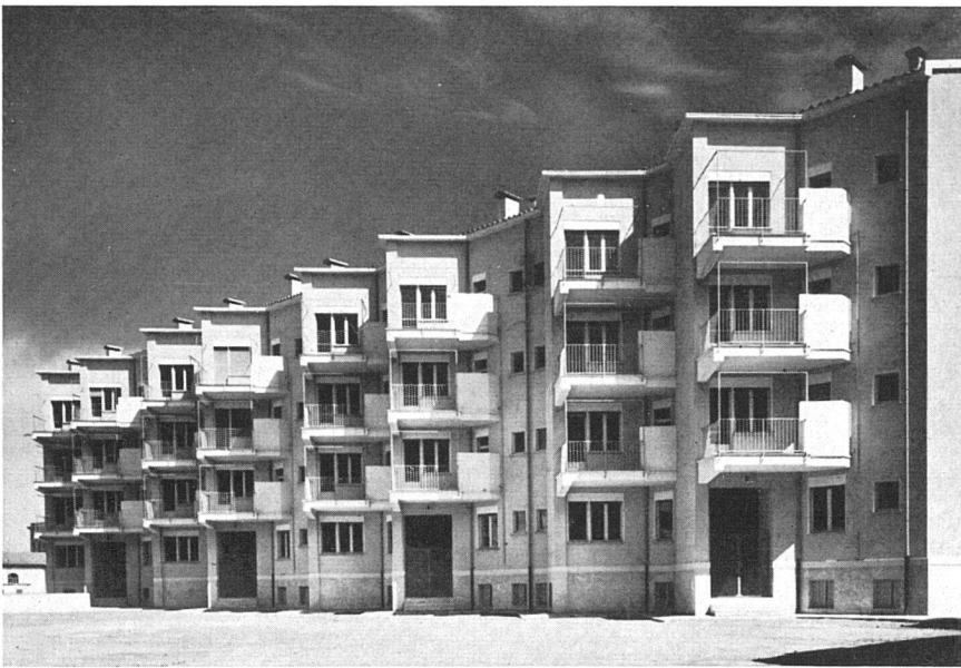
Gestaffelter Wohnblock C von Süden. Architekten G. Pediconi und M. Paniconi | Immeuble C; vue prise du sud | Block of flats C, from the south
