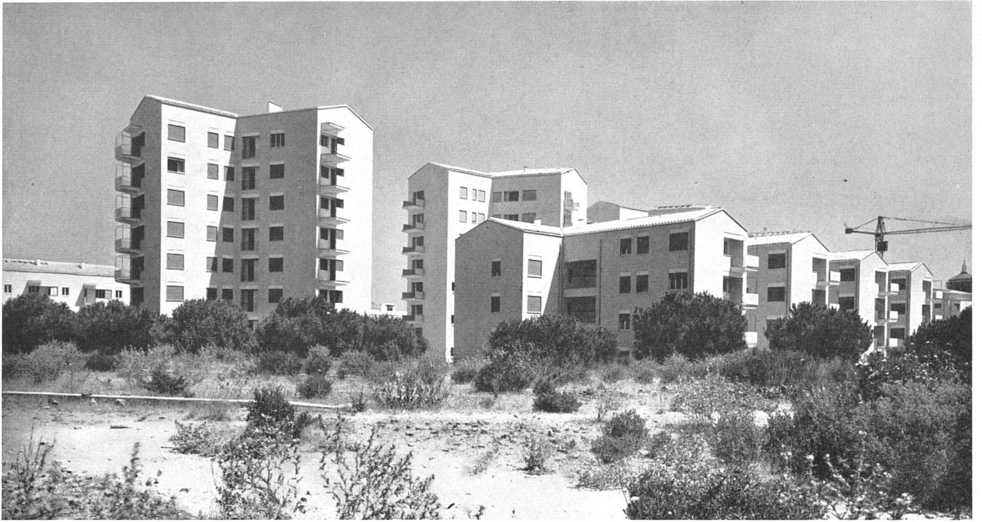
Ansicht des Wohnquartiers von Südwesten, rechts viergeschossige Mietbauten | Vue générale prise du sud-ouest | General view from the south-west Photos: A. Cartoni, Rom
