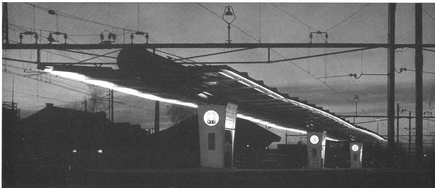
12 Die fertige Bahnsteiganlage bei Nacht | La marquise achevée, vue prise la nuit | The completed shelter by night
