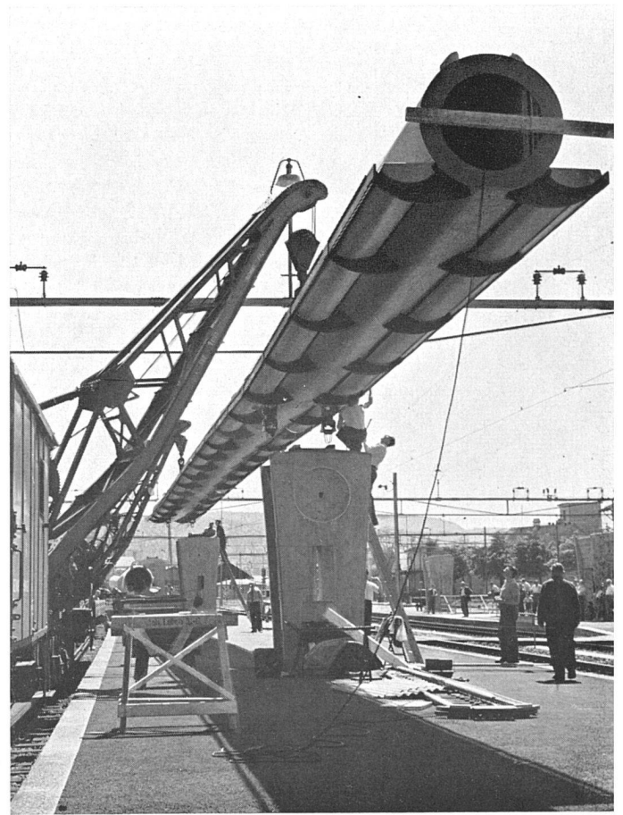
4 Montage des Hauptträgers, Teilstück von 54 m Länge | Montage de la poutre tubulaire; première partie longue de 54 m | Erection of the tubular beam, 1st part 54 m of length
