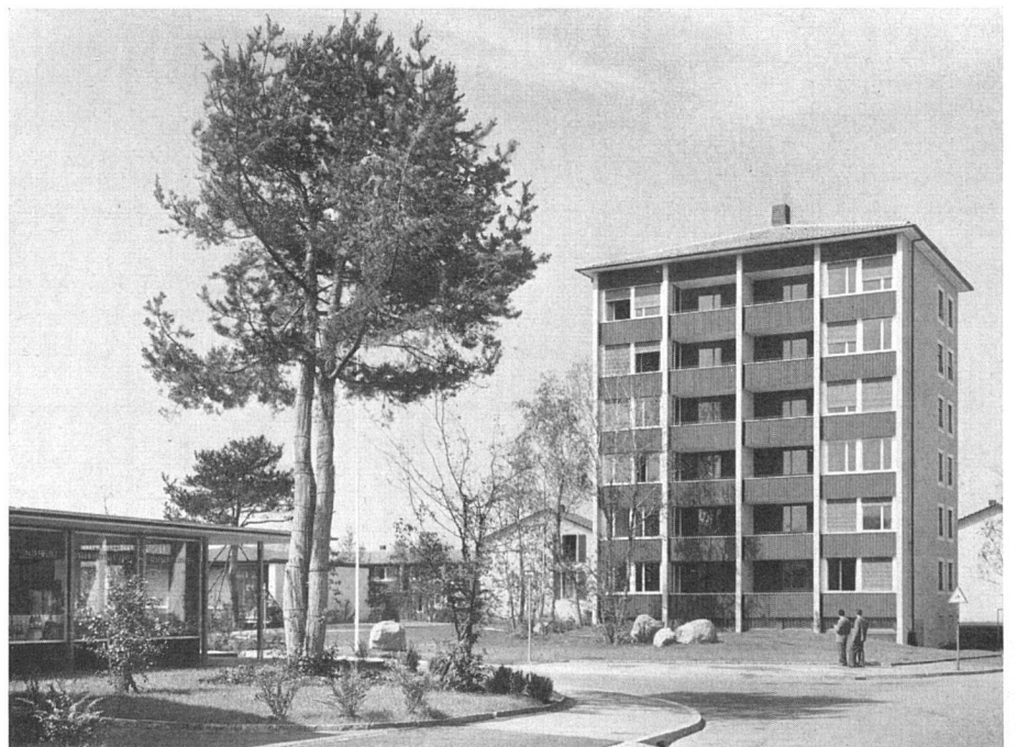
Laden, Kleinschulhaus und Turmhaus | De g. à dr., magasin, école, immeuble locatif | From l. to r., food shop, school, block of flats
