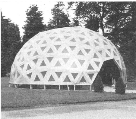
Kugelhaus aus genormten Dreieckselementen aus Karton; System Buckminster-Fuller, USA | Iglou composé d'éléments triangulaires en carton | The Buckminster-Fuller house made of triangular cardboard elements
