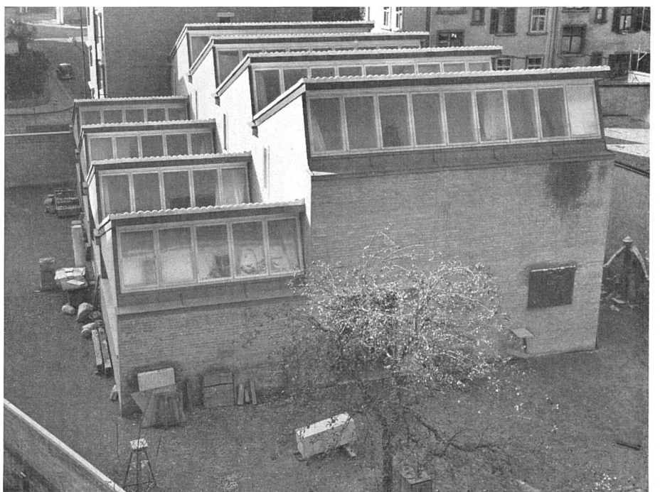
Die Ateliers von oben, l. Bildhauer, r. oben Maler | Les ateliers, à g. pour sculpteurs, à dr. et en h. pour peintres; vue prise du nord | The artist-studios from the north, at l. for sculptors, at r. and on first floor level for painters
