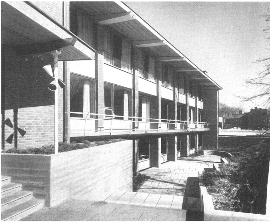
Der dreigeschossige Flügel von Südwesten; links der Haupteingang | L'aile à trois étages; à g., l'entrée principale. Vue prise du sud-ouest | The three-storey wing from the south-west, at l., the main entrance
