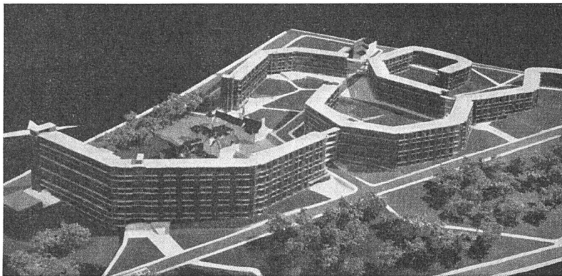
Wohnbebauung in Sheffield (England). Stadtbaumeister J.L. Womersly. Dieses demnächst zur Ausführung gelangende großzügige Projekt verdient besondere Beachtung wegen folgenden Eigenschaften: Bewußte räumliche Bebauungsform. Zweigeschossige Wohnungen von Laubengängen zugänglich. Gleichbleibende Dachhöhe und Ausnutzung des Geländegefälles für verschieden hohe Wohnbauten. Modellansicht. (Aus: The Architects' Journal, London)
