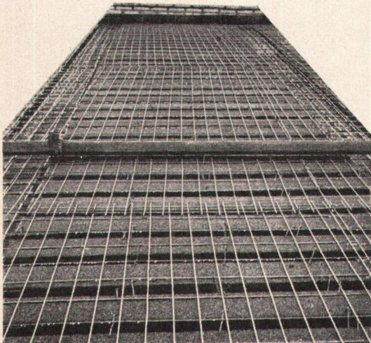
Je besser die Isolation, umso geringer die Heizkosten. Die Ersparnisse an Heizkosten machen im Laufe der Jahre oft ein Vielfaches dessen aus, was eine gut isolierende Decke mehr kostet. Mit BAUKORK-Isolierdecken – K-Werte zwischen 0,58 und 0,68 – bauen Sie bei Wegfall von Gefällsbeton etc. sogar noch billiger!
