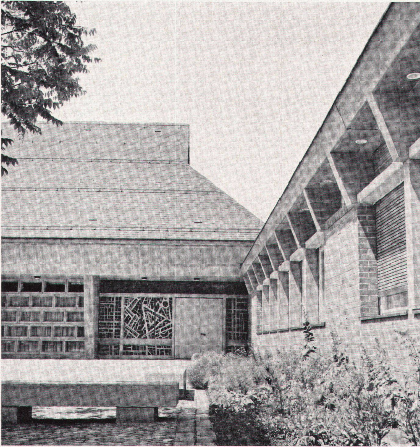
4 Der Hof, im Hintergrund das Glasbild von Charles Hindenlang La cour, au fond le vitrail de Charles Hindenlang Courtyard with, in the background, glass painting by Charles Hindenlang
