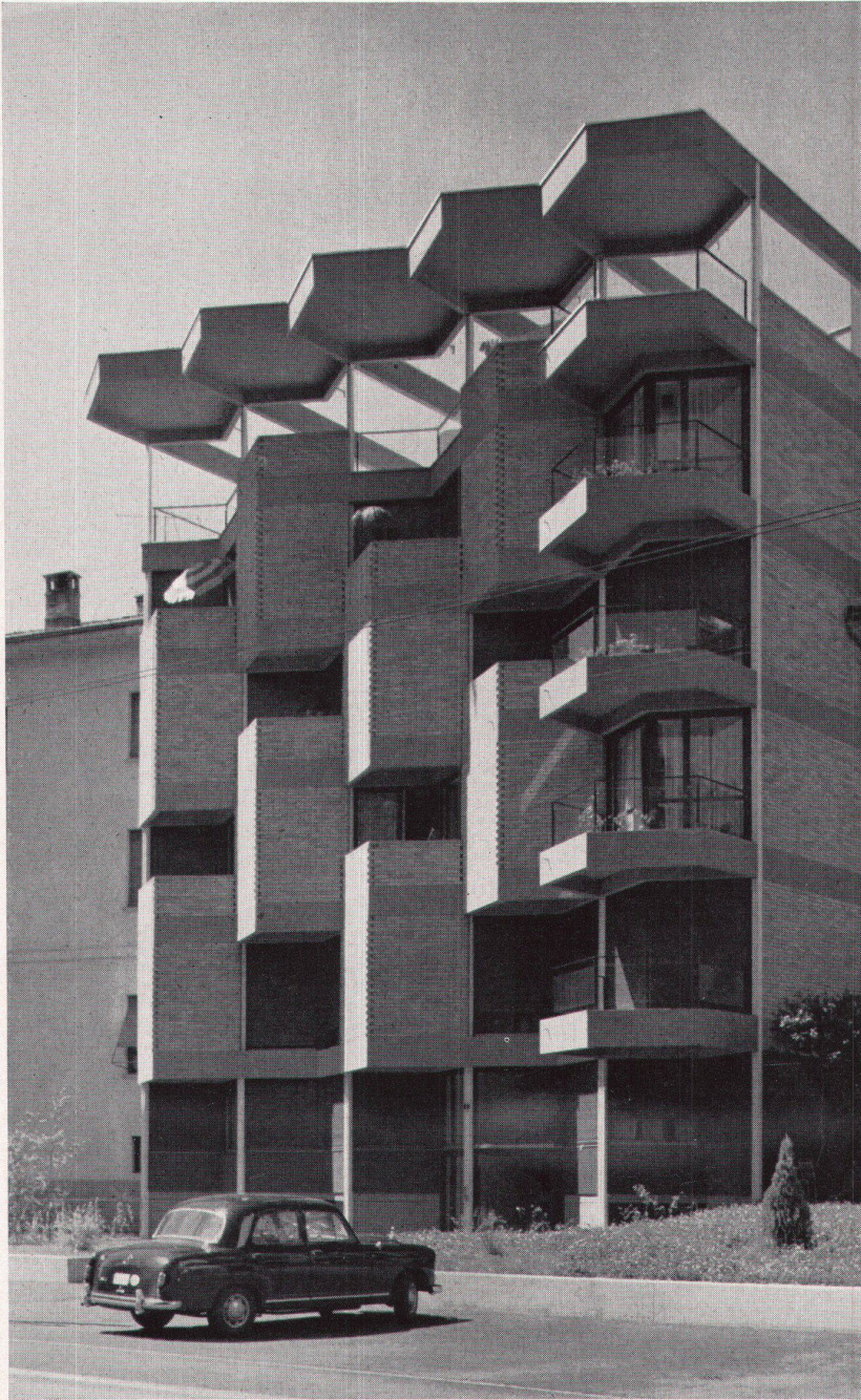
1 Fassadendetail Détail de la façade Part view of the front face
