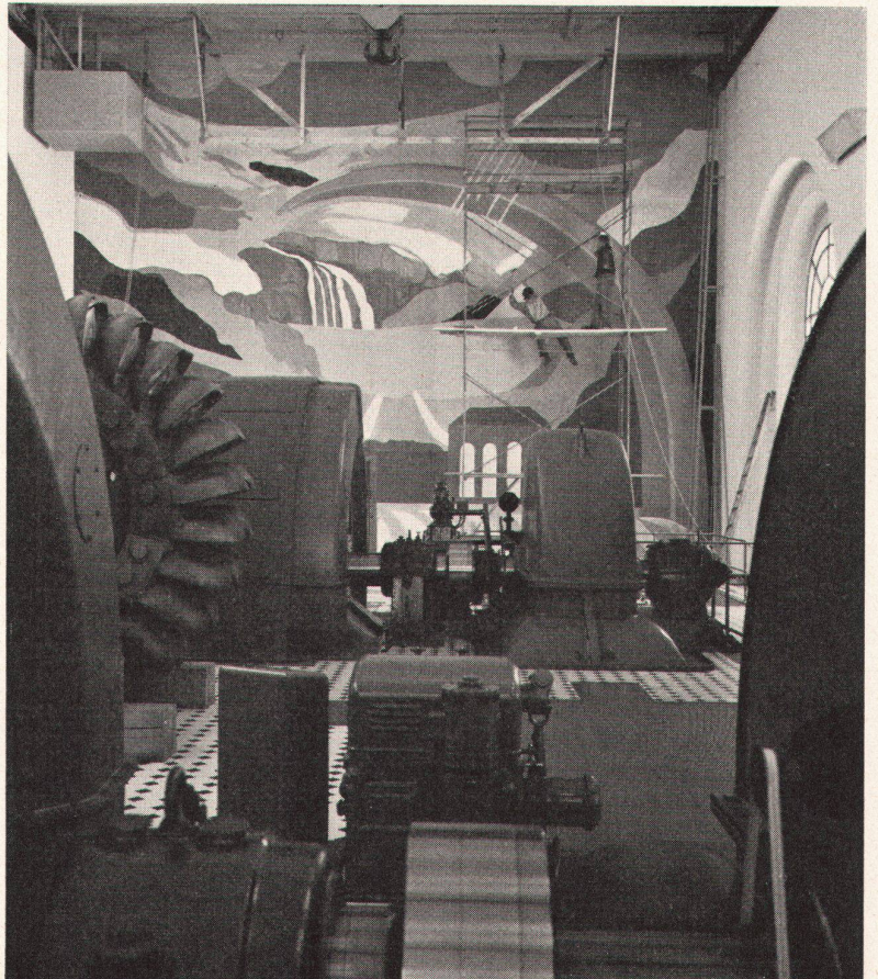
Turo Pedretti, Wandbild in der Kraftwerkzentrale Robbia
