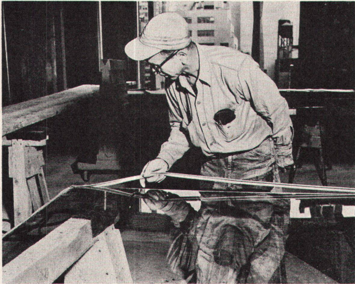
Neoprene-Dichtung mit vorgeformten Ecken und U-förmigem Querschnitt lässt sich auf der Baustelle rasch anbringen.
