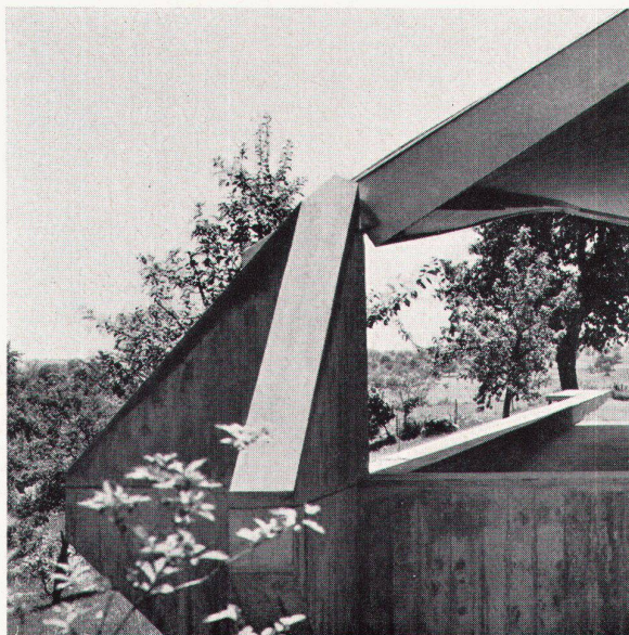
6 Ostterrasse mit einem der beiden Eckpfeiler, welche das Hauptgewicht des Daches tragen Terrasse est avec un des deux piliers d'angle qui supportent le poids principal de la toiture Eastside terrace with one of two corner pillars bearing the main load of the roof
