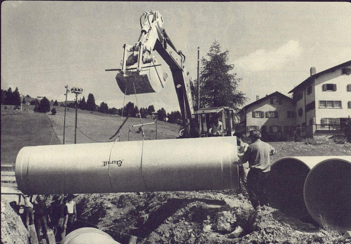
Das Asbestzement-Kanalisationsrohr «ETERNIT» ist ein Spitzenprodukt für den zeitgemässen Kanalisationsbau.
