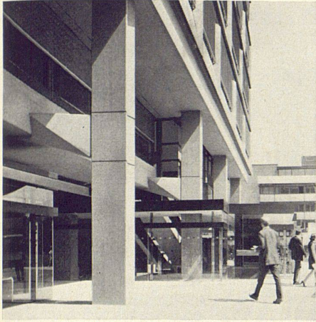
7 7-9 Im Erdgeschoß ist der Bau auf Stützen gestellt. Drei verglaste Zonen, die teilweise über den Block hinausreichen, lassen einen Y-förmigen Durchgang frei. Eine Rolltreppe führt den Kunden zu den Bankräumen 10, 11
